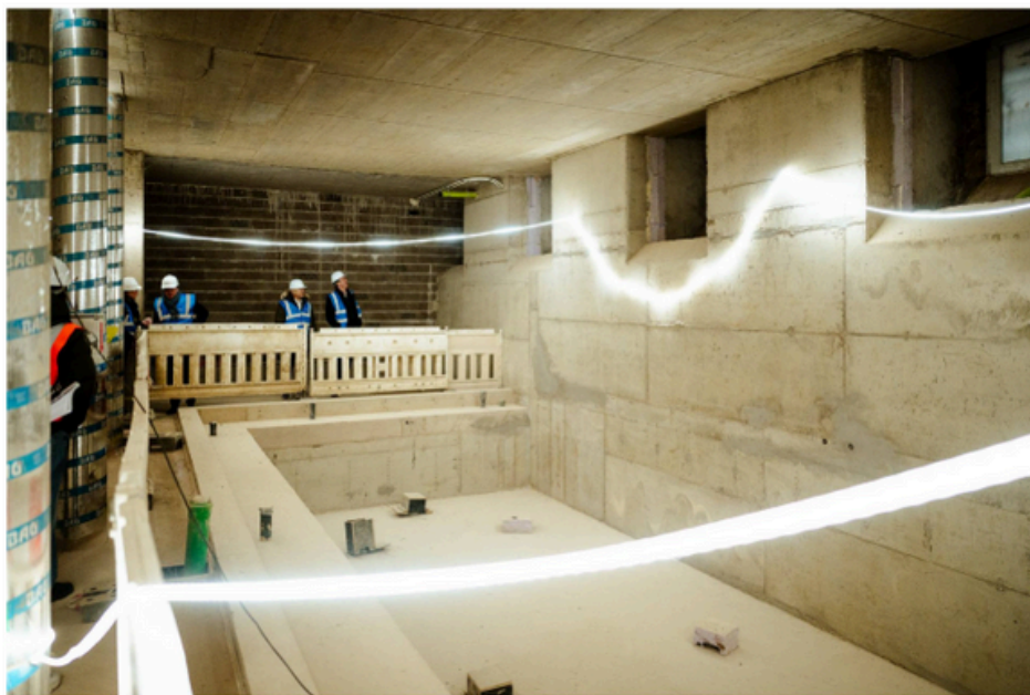
■ Au sous-sol, une piscine a été construite. (Photo: Post Luxembourg / Anouk Flesch)
