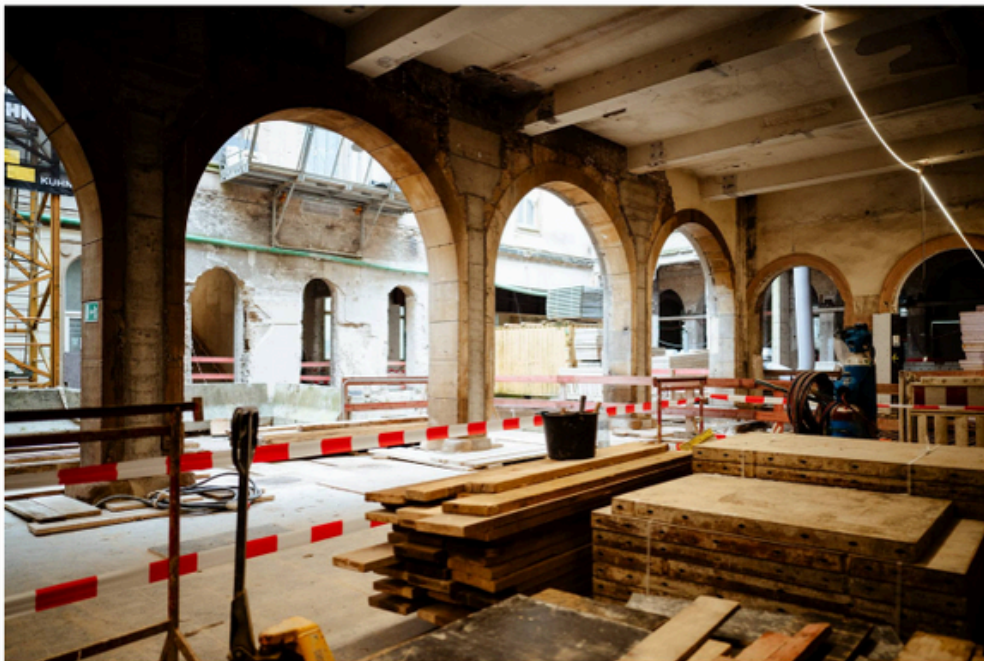
Les travaux sont encore en cours, mais bientôt un boutique-hôtel se tiendra dans l'ancien hôtel des Postes à Luxembourg. (Photo: Post Luxembourg / Anouk Flesch)
